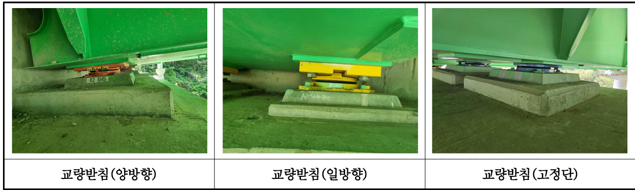
【사진 20.3.15】 교량받침 전경
