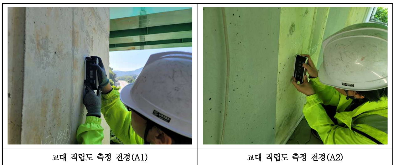
【사진 20.3.11】 교대 직립도 측정 작업사진 전경
