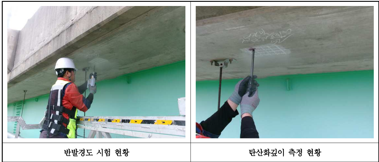
【사진 20.4.1】 콘크리트 내구성조사 현황
