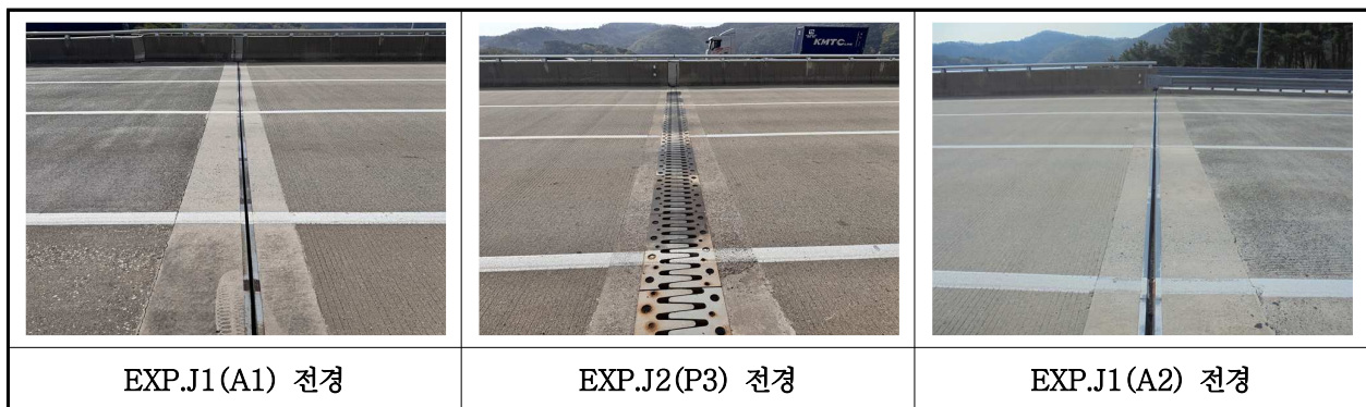
【사진 20.3.19】 신축이음장치 전경
