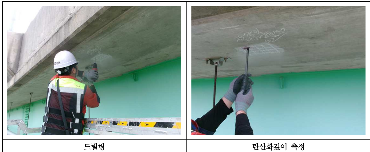
【사진 20.4.3】 탄산화 깊이 측정 현장사진
