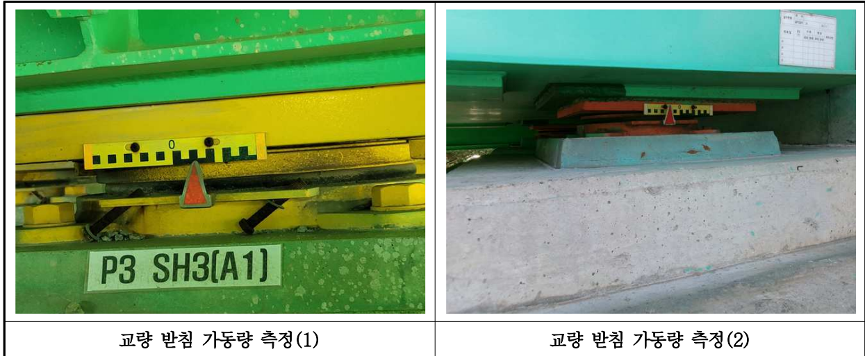
【사진 20.3.18】 교량받침 이동량 측정
