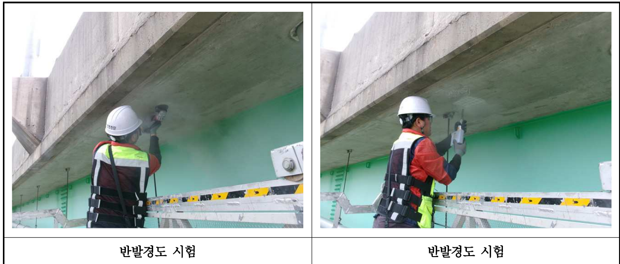
【사진 20.4.2】 반발경도시험 현장사진
